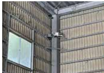
1.監視「熱画像センサー」 広範囲の温度異常を画像監視します。
