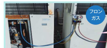
フロンガス回収後、内装解体を行いました
