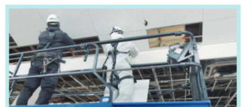
内装解体が完了してから上屋の解体を開始
