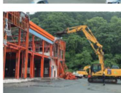
フジバチンコを解体
