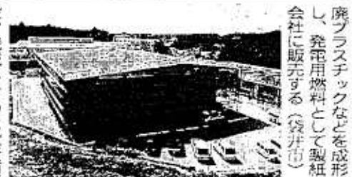
袋井市に建設中の産廃を原料とした固形燃料の製造工場。発電用燃料として製紙会社に販売する(袋井市)
