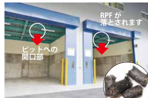
工場内部で作られたRPFは開口からトラック等に積載が容易な外部ピットに落とされます。
