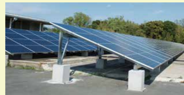
都田太陽光発電所 パネル枚数 624枚 最大発電量 159.12kw/h
