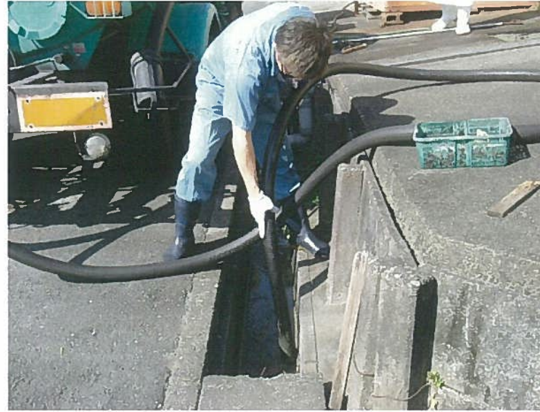
⑭排水側溝の清掃にて作業終了
