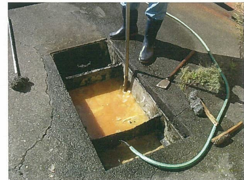
⑥容器内汚物吸い込み
