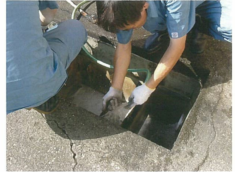
⑨容器内汚物吸い込み
